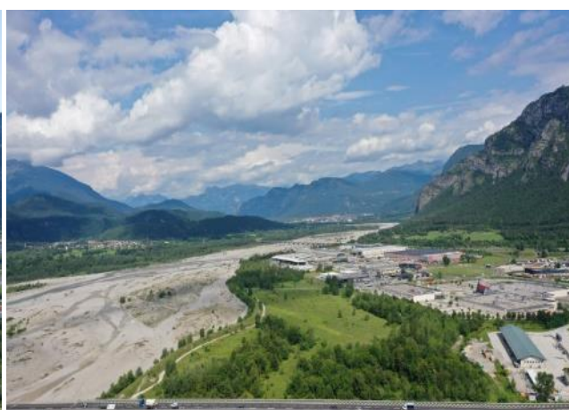
Panoramica in direzione Nord-Ovest
